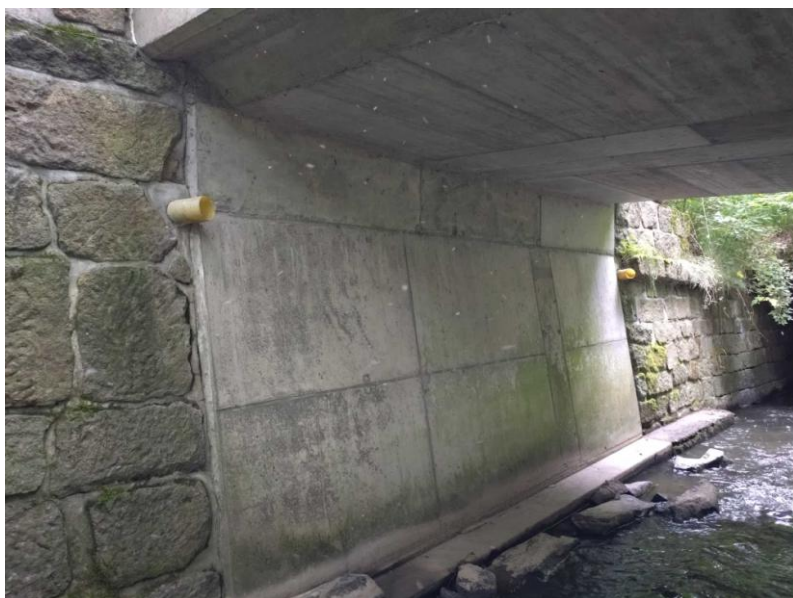
Levobřežní opěra s e špatně zhutněným povrchem.
