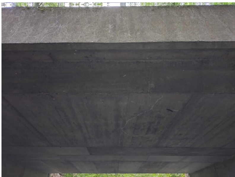
Podhled nosné konstrukce od vtoku s lokálními kavárničkami po nekvalitním zhutnění
