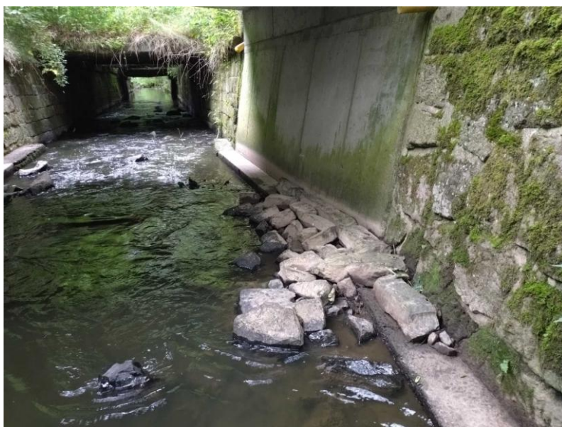
Odplavené opevnění pat opěr a lokálně vymleté opevnění dna.
