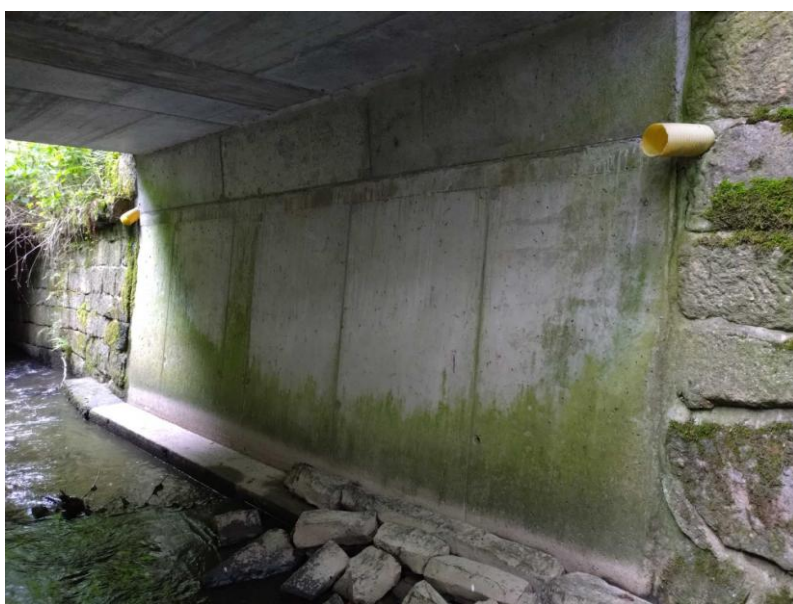
Pravobřežní opěra se zeleným povlakem
